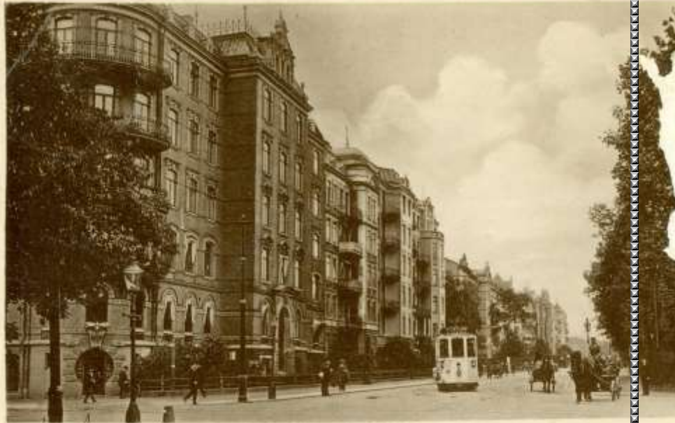
Södra Vägen, Göteborg.
